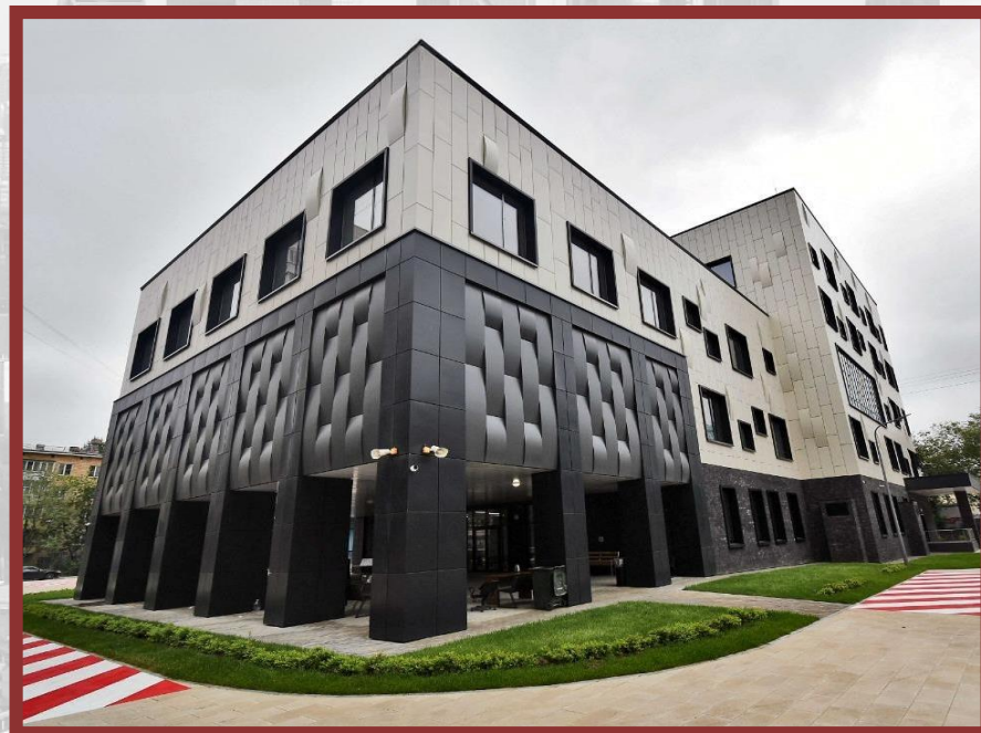
Большой Тишинский пер., д. 39 (Учебный корпус на 300 мест)
